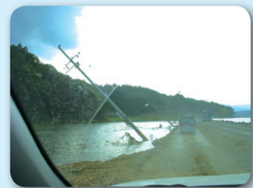
石巻市被災地へ続く仮道路にて
